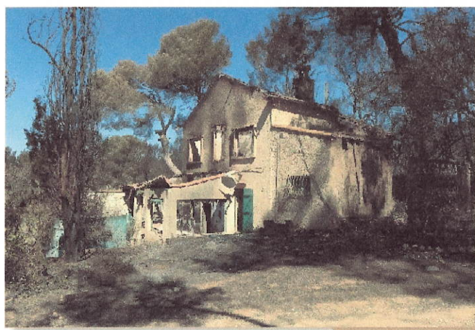
Maison non débroussaillée partiellement détruite par le passage d'un feu, Rognac (13) - source : GNF
